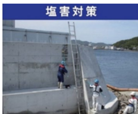
写真 3：リアクトライズ®&カルサプリ®の施工事例
