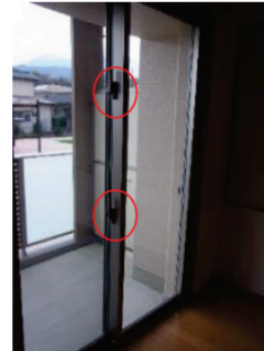
写真Ⅱ.5 2 か所（1 か所は小さな子どもの手の届かない高さ）に取り付けられたクレセント錠
