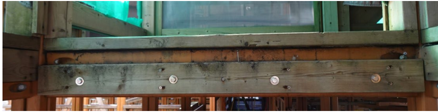
写真27 床受け木の接合状態
