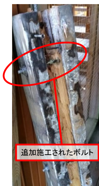
写真7 梁の西側端部の破断面の様子（再掲）
