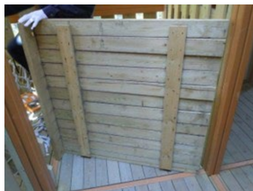
写真30 落下した床板
