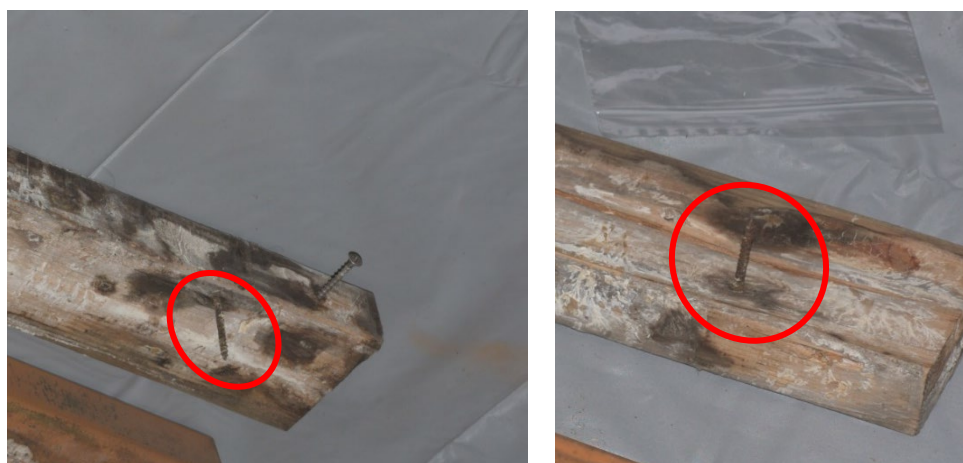
写真 11 床受け木に打ち込まれていたコーススレッド（木ネジ） （左：南面、右：北面）
