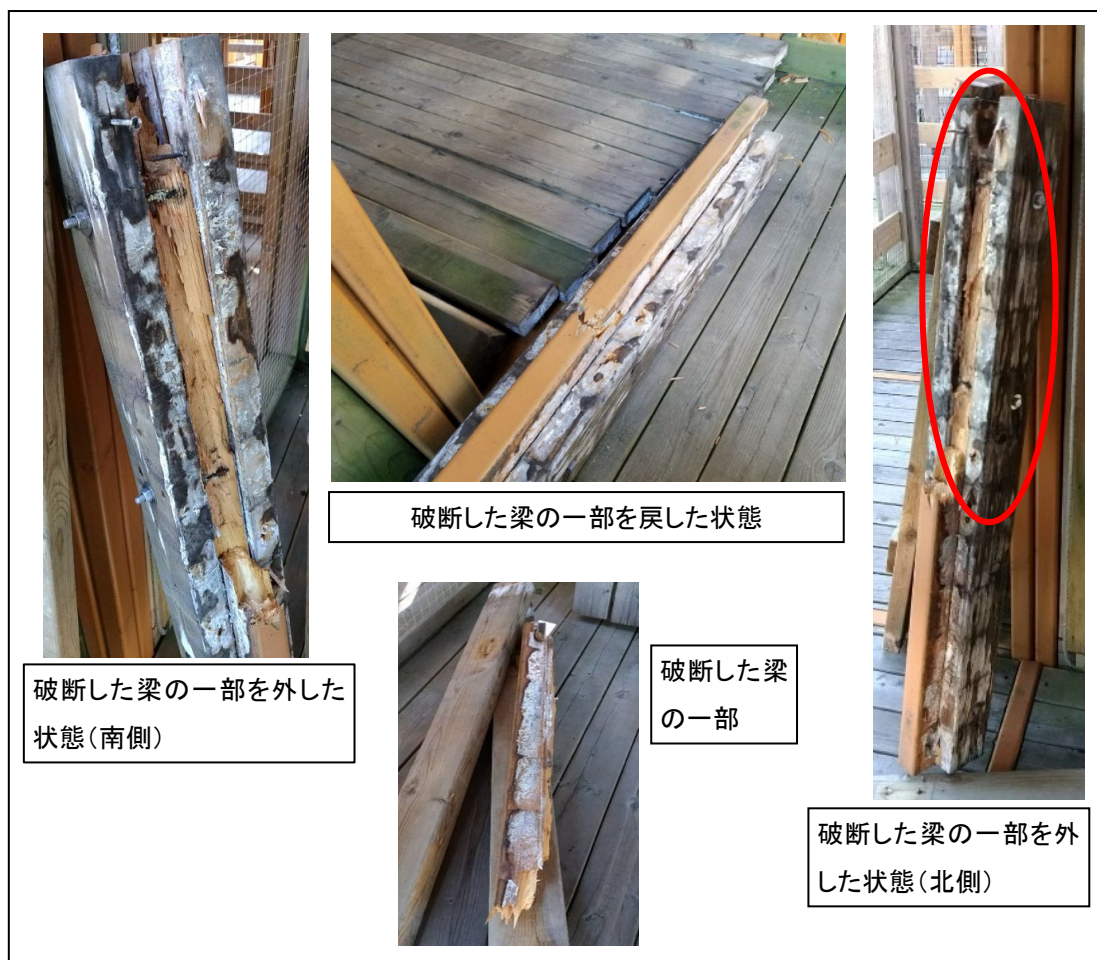
写真5 落下した梁と床受け木の状態
