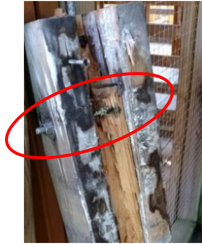
写真 15 ボルトへの菌糸の付着（再掲）
