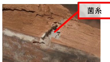
写真11 梁西端部下及びボルト孔（約1年3か月後に撮影）
