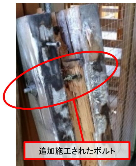
写真9 梁西端部の破断面及びボルト
