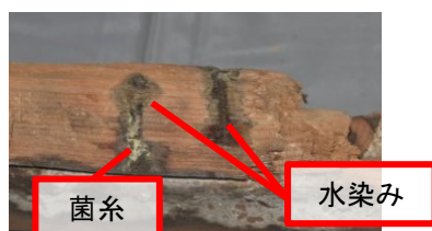
写真10 梁西端部上部及びコーススレッド孔
