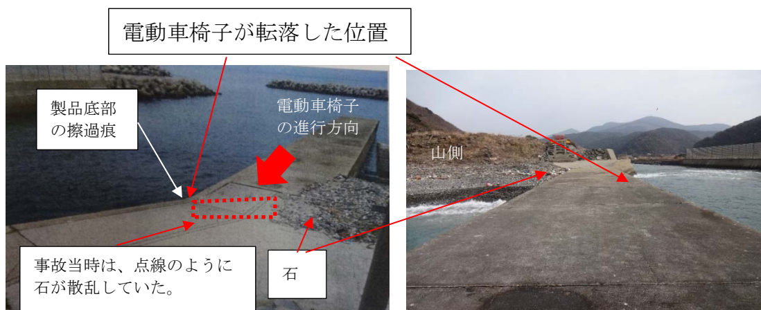
A：防波堤（陸側から撮影した写真）
