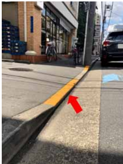
写真 20 車道と歩道の段差 5 cm の例（矢印）
