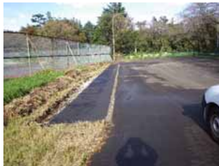
エリア 3（傾斜面）
