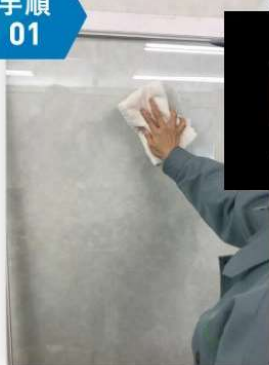
窓の下地清掃
